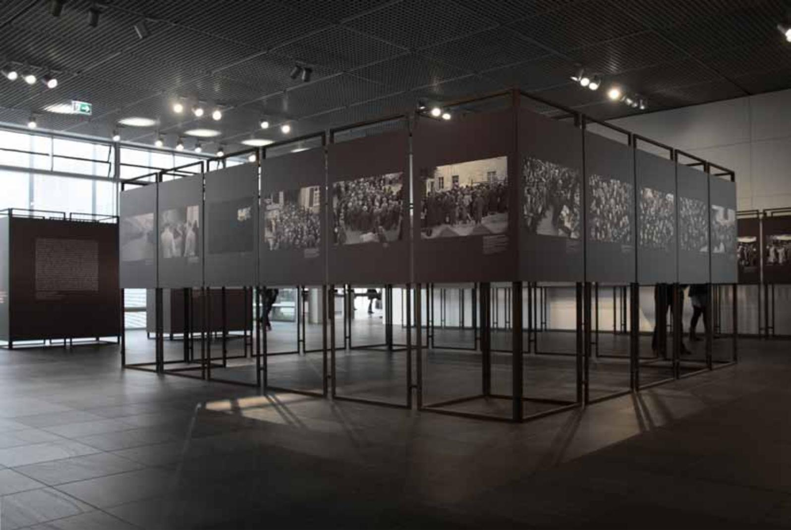
Stellwände aus Vierkantstahlrohr (25 mm)
